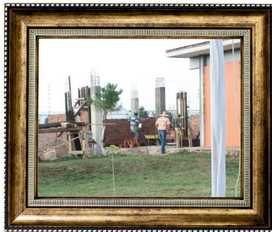
Construcción de los edificios C y D
